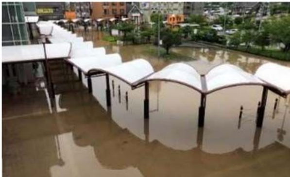
■平成30年7月豪雨時の赤間駅南口の浸水被害
