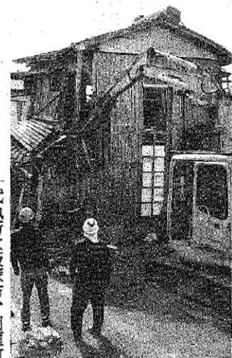
解体される空き家
