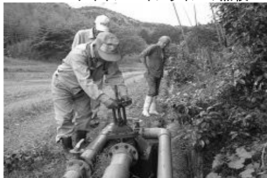
サイホンパイプラインの点検
