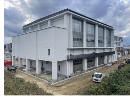
東側施工状況写真
