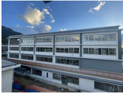
西側施工状況写真
