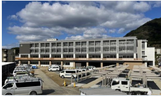
南側施工状況写真
