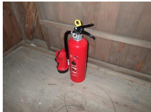
市指定 梅谷寺千手観音立像 保存環境整備(消火器設置)
