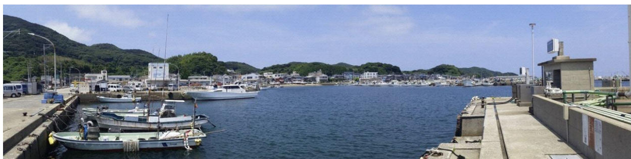
大島港からみた大島のまちなみ
