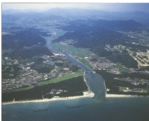
江戸時代に川筋を直線にする改修工事が行われた釣川河口
