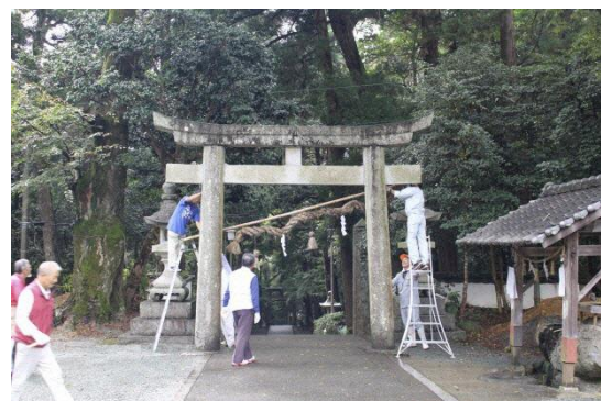
しめなわ 注連縄の張替え作業
