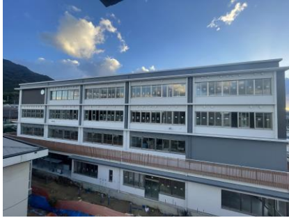
西側施工状況写真
