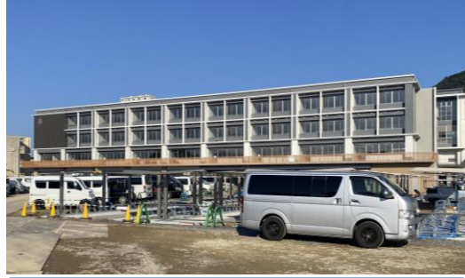
南側施工状況写真
