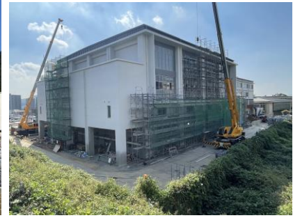
東側施工状況写真
