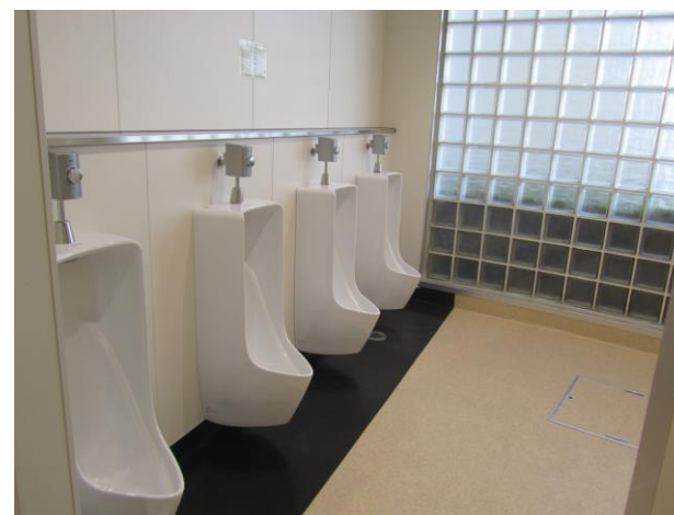
トイレの大規模改修
