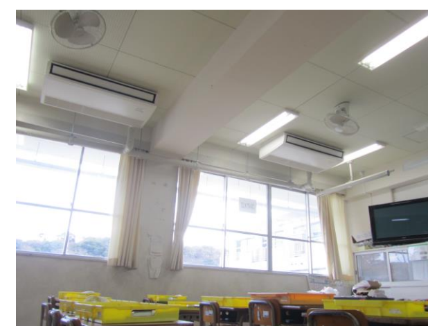
普通教室の空調設備整備
