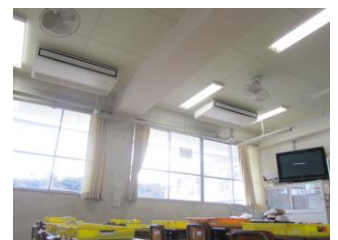
普通教室の空調設備整備
