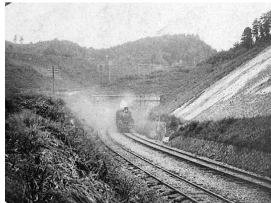
写真 交通の要衝にある城山トンネル
