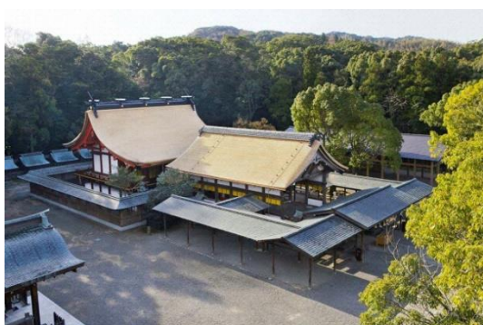
写真 国指定文化財(重要文化財) 宗像神社辺津宮本殿(奥)拝殿(手前)
