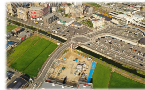
< 令和3年3月完成 市道平井10号線 >
