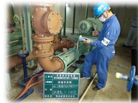
濃縮汚泥引抜ポンプのデータ測定
