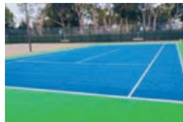
改修工事中のテニスコート
