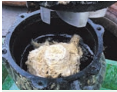
マンホールポンプの故障（紙おむつ、タオルなど布類の詰まり）
