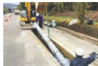
水道管の取り替え工事
