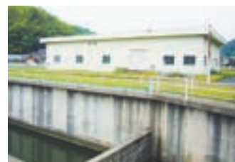
釣川から水をくみ上げている吉田取水場
