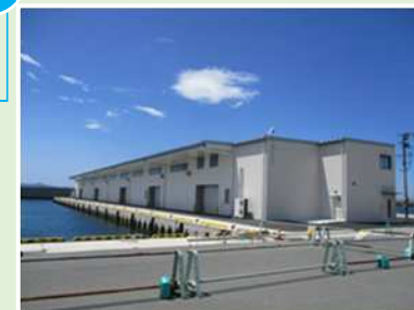
鐘崎漁港荷捌所の外観
