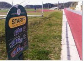
③ ジョギングコース 足腰に負担が少ないゴムチップ舗装
