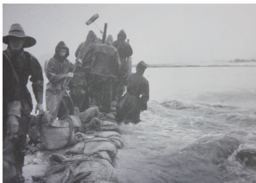
濁流の中、土のうで堤防を築く
