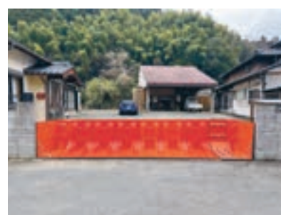
連結式の止水板(一般住宅の入口)。
