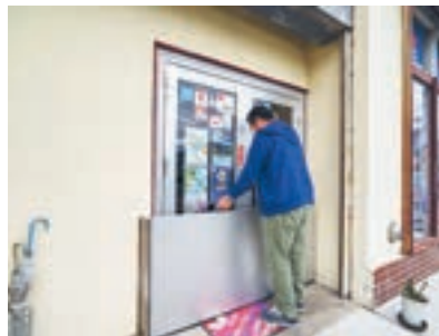
入口ドア前に設置する着脱式の止水板。
