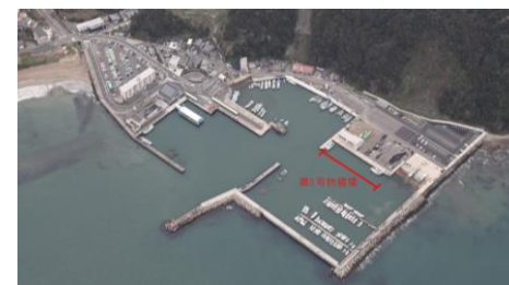
耐震耐津波対策工事を実施する 神湊漁港 第3号物揚場
