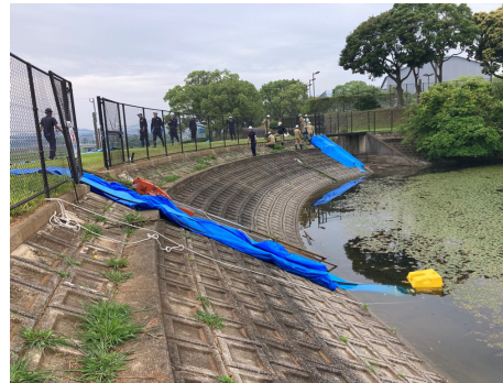
排水ポンプ稼働訓練
