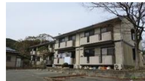
大規模改修実施設計を行う前田団地
