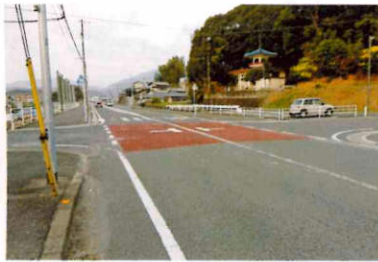
后曲交差点カラー舗装
