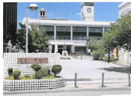
寝屋川市役所の正面玄関
