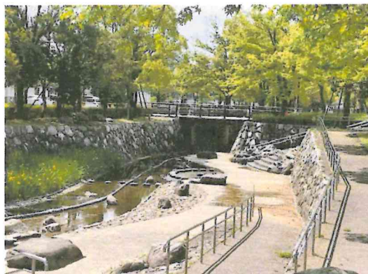
中央公園内にある大雨時の貯留施設
