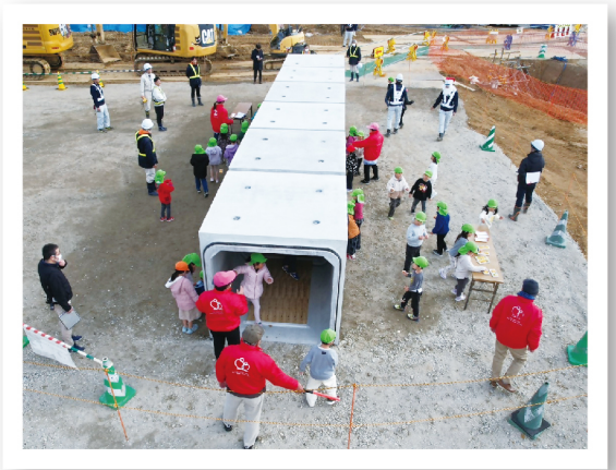
赤間雨水幹線改築工事見学会
