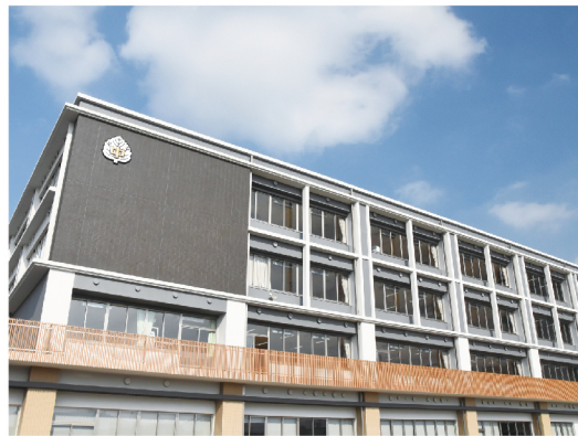
体育館空調を整備した城山中学校の外観
