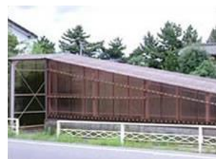
硬質塩化ビニール波板の外壁
