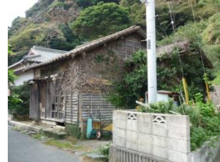
裸木造の外壁
