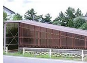
硬質塩化ビニール波板の外壁
