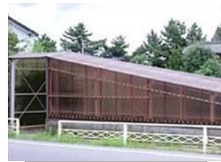
硬質塩化ビニール波板の外壁
