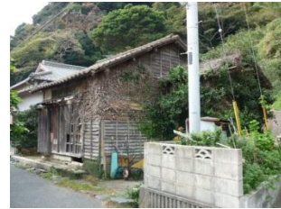
裸木造の外壁
