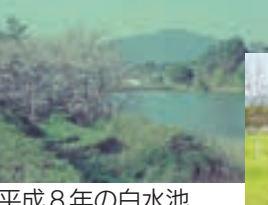
平成8年の白水池 現在の白水池
