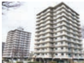
解体工事が始まった日の里1丁目団地の103、104号棟
