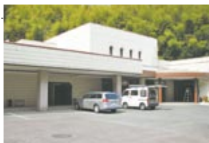
整備の基本計画策定のため建物調査を実施する火葬場施設(浄業苑)
