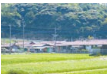
建て替えが予定されている荒開団地
