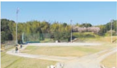
照明を設置中の明天寺公園
