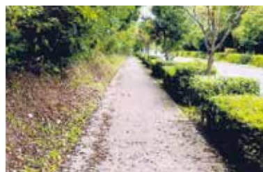
石丸河東線の歩道の状況
