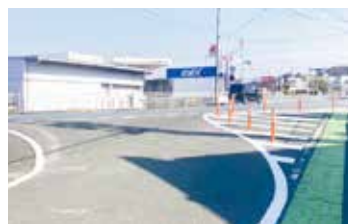
市道光岡1号線に設置されたポストコーン
