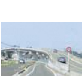
東郷村跨線橋
