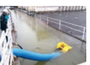
移動式ポンプ車活用の様子
