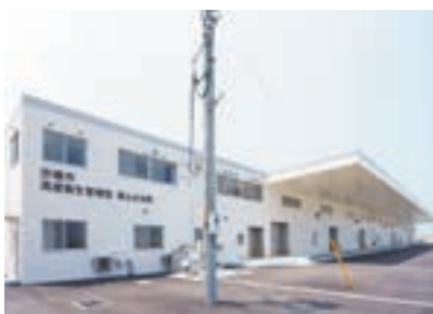
鐘崎に漁港で整備が進む 高度衛生管理型荷さばき所
