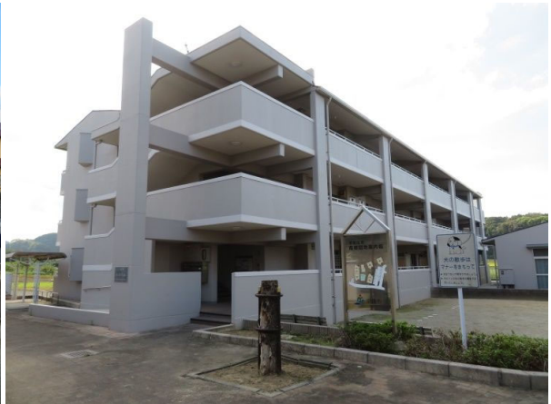
中層耐火構造 3F (玄関側)
