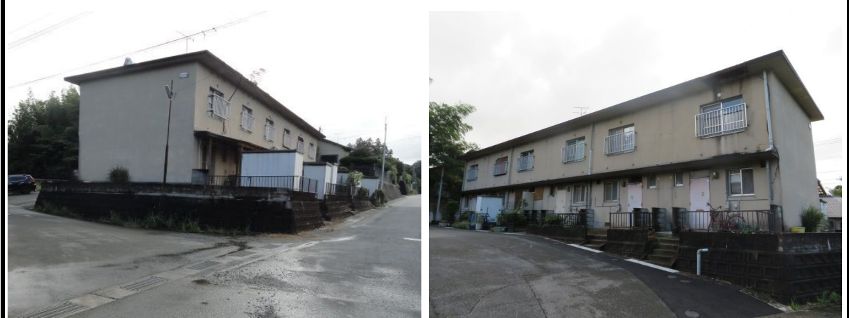
簡易耐火構造2F（庭側）
