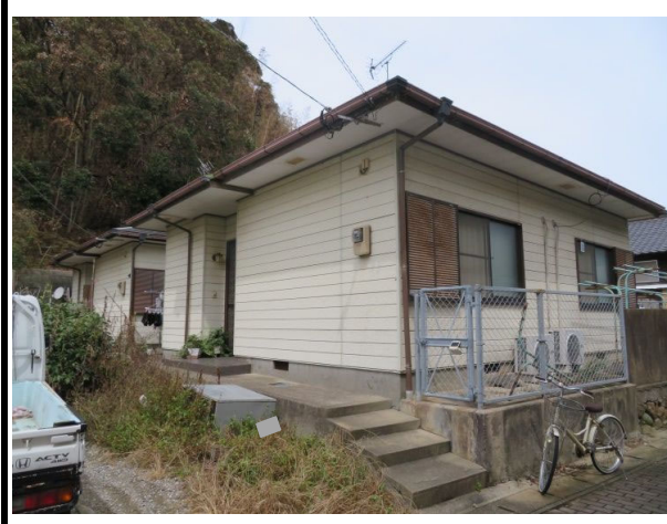
木造平屋 (全景)
