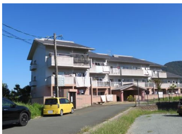
中層耐火構造 3F (ベランダ側)
