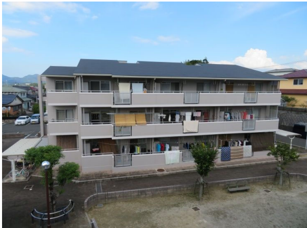
中層耐火構造 3F (ベランダ側)
