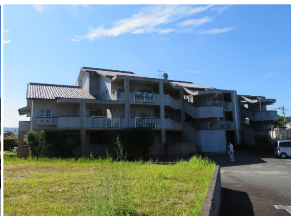
中層耐火構造 3F (玄関側)
