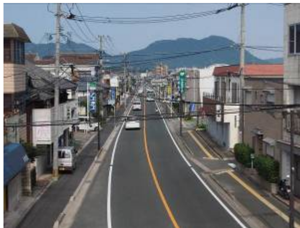
▲県道 97 号（田熊付近）
