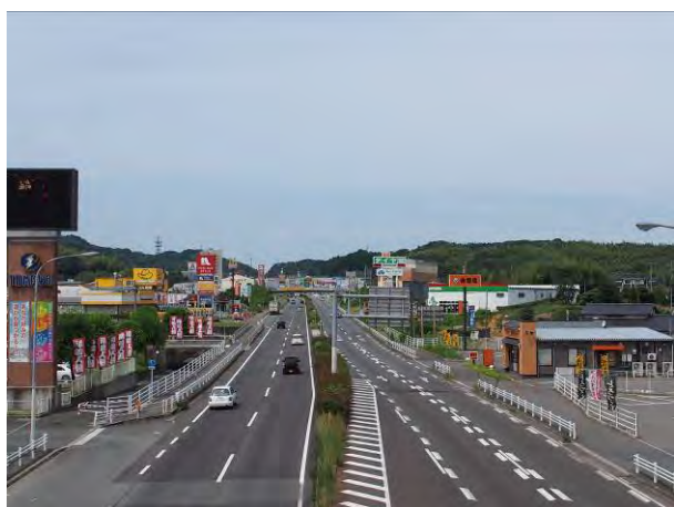
▲国道3号（光岡付近）
