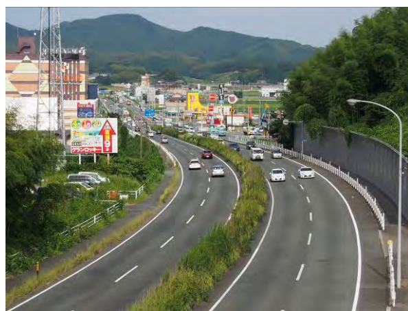
▲国道3号（徳重付近）
