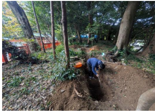
宗像大社中津宮防災設備整備事業
