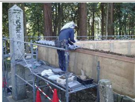
八所宮の土塀修復
