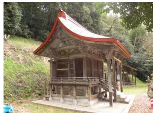
稲元八幡宮本殿
