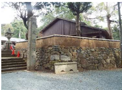
八所宮石垣及び土塀保存修復
