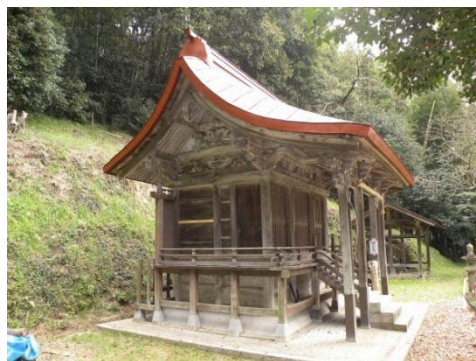
稲元八幡宮本殿
