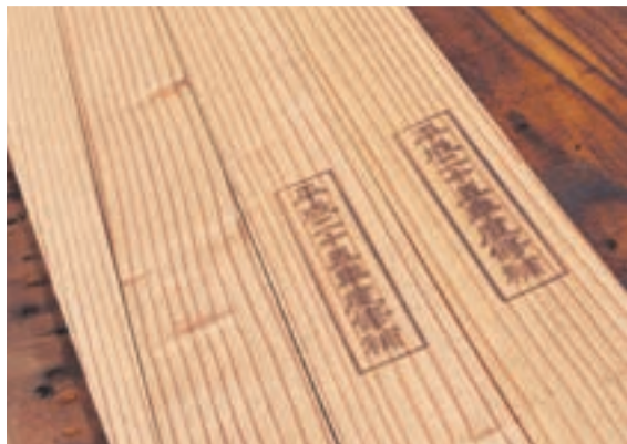
交換時期が刻印された部材
