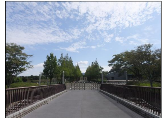
写真②：歩道橋
