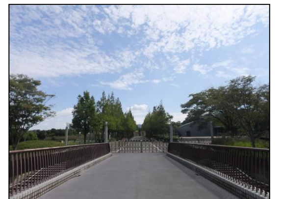
写真②：歩道橋
