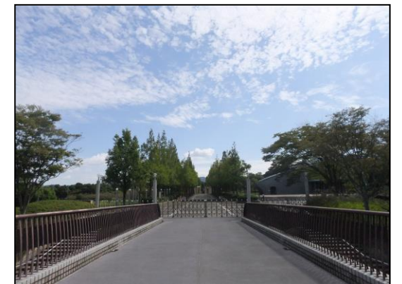
写真②：歩道橋
